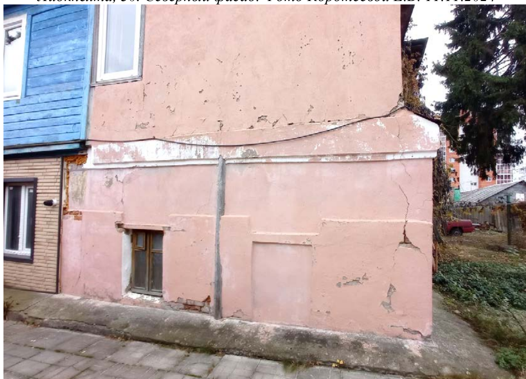
Фото 6. Выявленный объект культурного наследия «Дом жилой», г. Курск, ул. Карла Либкнехта, 30. Фрагмент северного фасада. Фото Коротеевой Е.В. 11.11.2024
