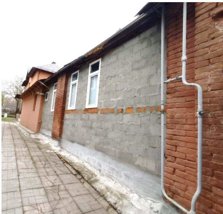
Южный фасад. Общий вид
