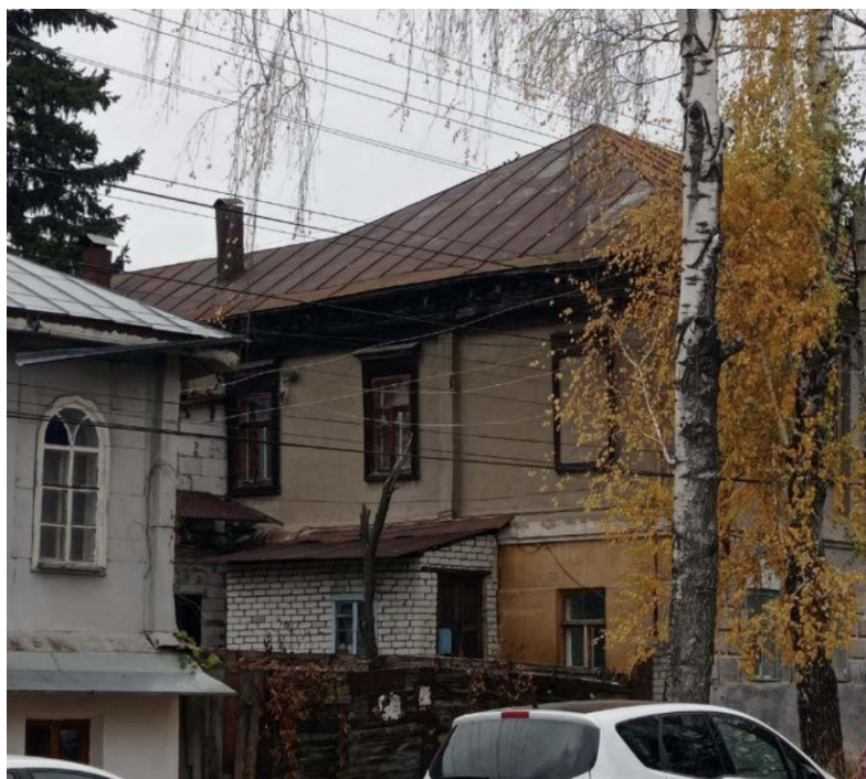
Фрагмент южного фасада. Общий вид
