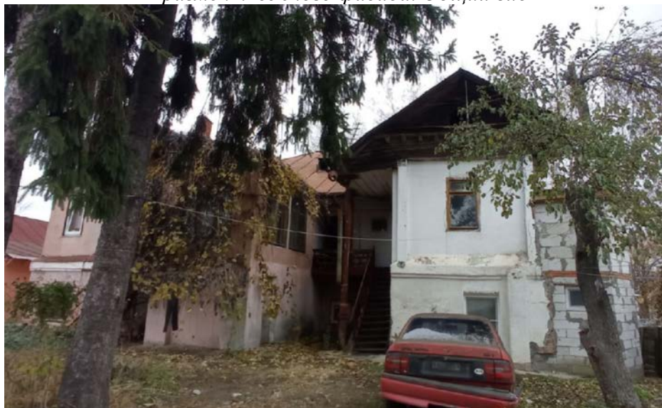
Южный фасад. Общий вид
