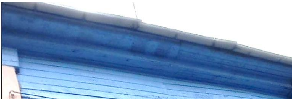
Северный фасад. Венчающий карниз
