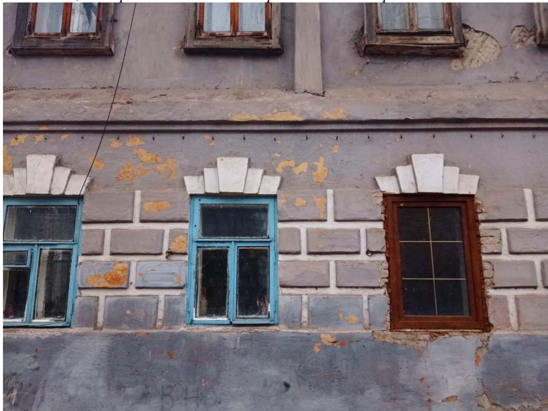
Фото 4. Выявленный объект культурного наследия «Дом жилой», г. Курск, ул. Карла Либкнехта, 30. Фрагмент восточного фасада. Фото Коротеевой Е.В. 11.11.2024
