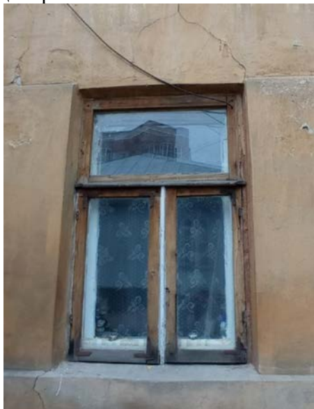
Южный фасад. Оконный проем первого этажа
