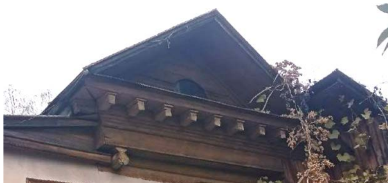
Западный фасад. Фронтон со слуховым окном
