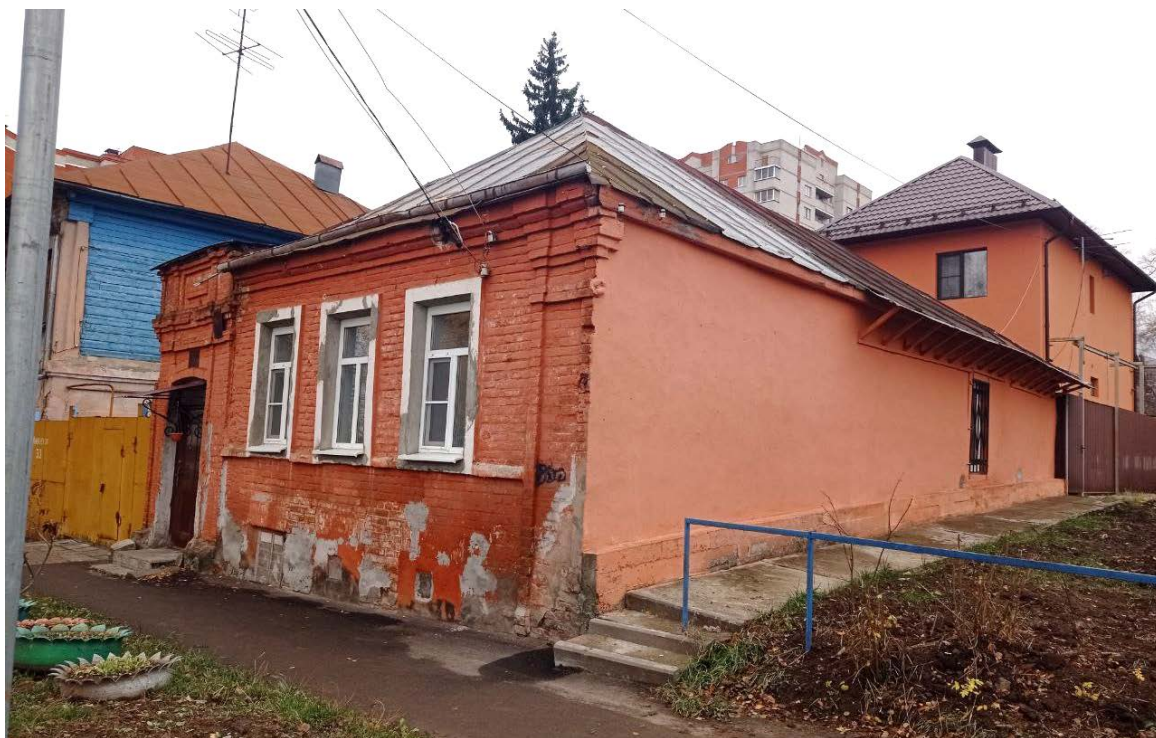
Фото 17. Выявленный объект культурного наследия «Дом жилой», г. Курск, ул. Карла Либкнехта, 30а. Северный и восточный фасады. Фото Коротеевой Е.В. 11.11.2024
