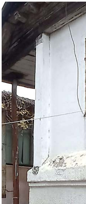
Западный фасад. Лопатка второго этажа
