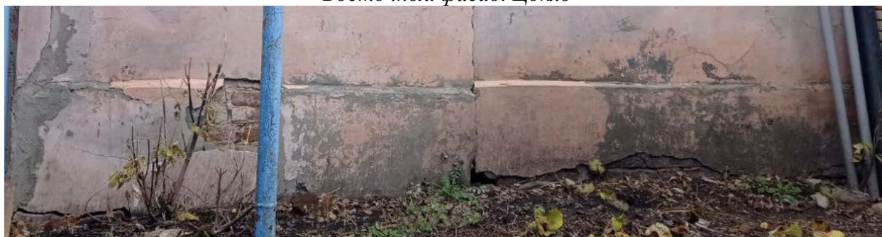
Северный фасад. Цокль
