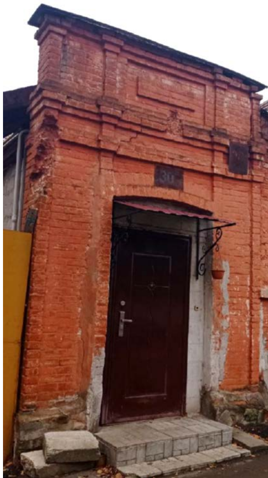
Восточный фасад. Входная группа
