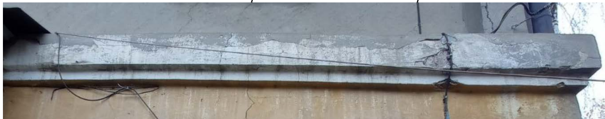
Южный фасад. Межэтажный карниз
