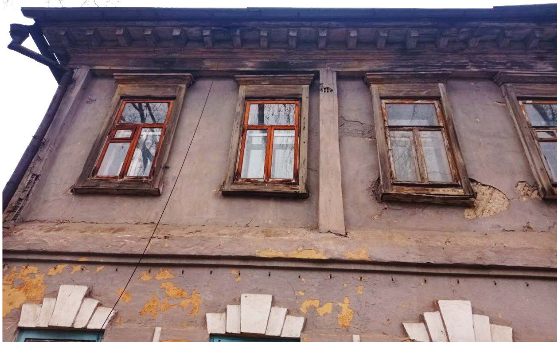
Фото 3. Выявленный объект культурного наследия «Дом жилой», г. Курск, ул. Карла Либкнехта, 30. Фрагмент восточного фасада. Фото Коротеевой Е.В. 11.11.2024
