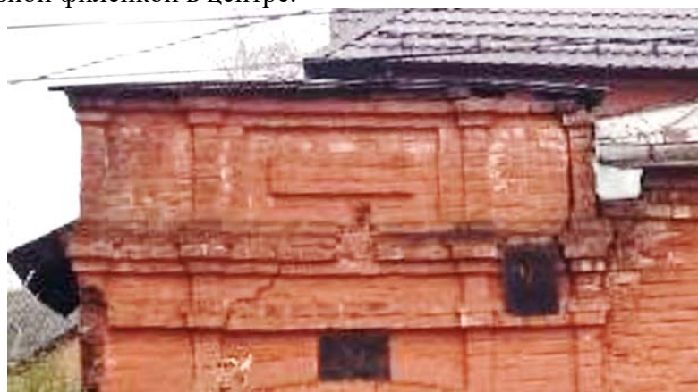
Восточный фасад. Атик
