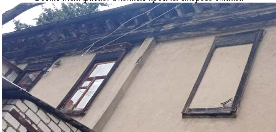
Южный фасад. Оконные проемы второго этажа
