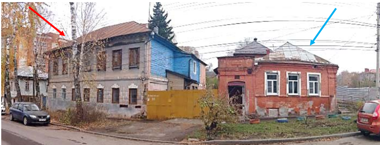
Фото 1. Выявленные объекты культурного наследия «Дом жилой», г. Курск, ул. Карла Либкнехта, 30 (указан красным цветом) и «Дом жилой», г. Курск, ул. Карла Либкнехта, 30а (указан синим цветом). Общий вид с востока. Фото Коротеевой Е.В. 11.11.2024
