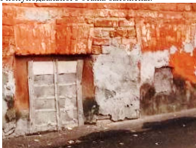
Восточный фасад. Оконные проемы
