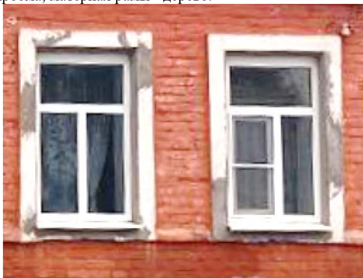
Восточный фасад. Оконные проемы
