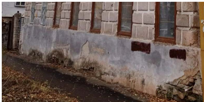
Восточный фасад. Цокль
