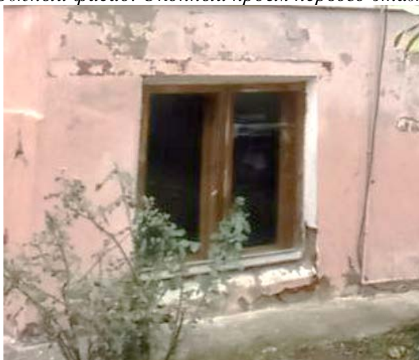
Западный фасад. Оконный проем первого этажа
