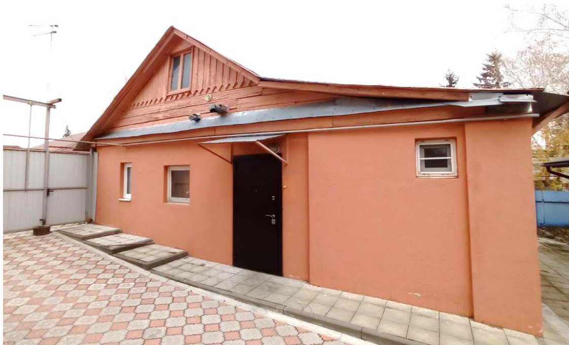
Фото 19. Выявленный объект культурного наследия «Дом жилой», г. Курск, ул. Карла Либкнехта, 30а. Западный фасад. Фото Коротеевой Е.В. 11.11.2024
