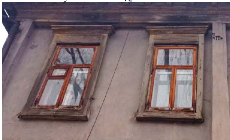
Восточный фасад. Оконные проемы второго этажа
