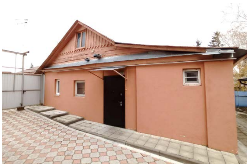
Западный фасад. Общий вид
