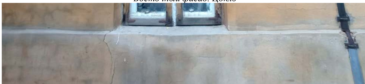
Восточный фасад. Цокль
