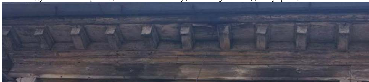
Восточный фасад. Венчающий карниз
