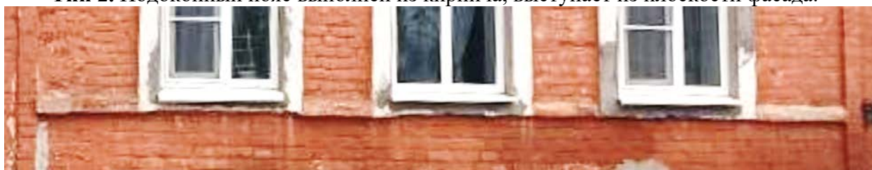
Восточный фасад. Подоконный пояс
