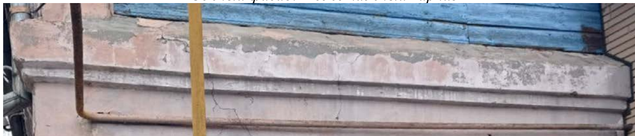
Северный фасад. Межэтажный карниз
