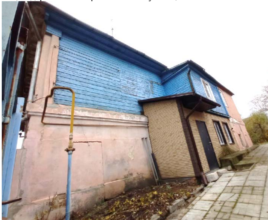
Северный фасад. Общий вид
