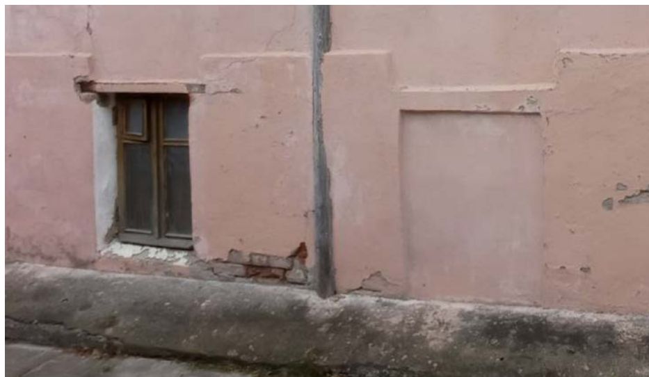
Северный фасад. Оконные проемы первого этажа
