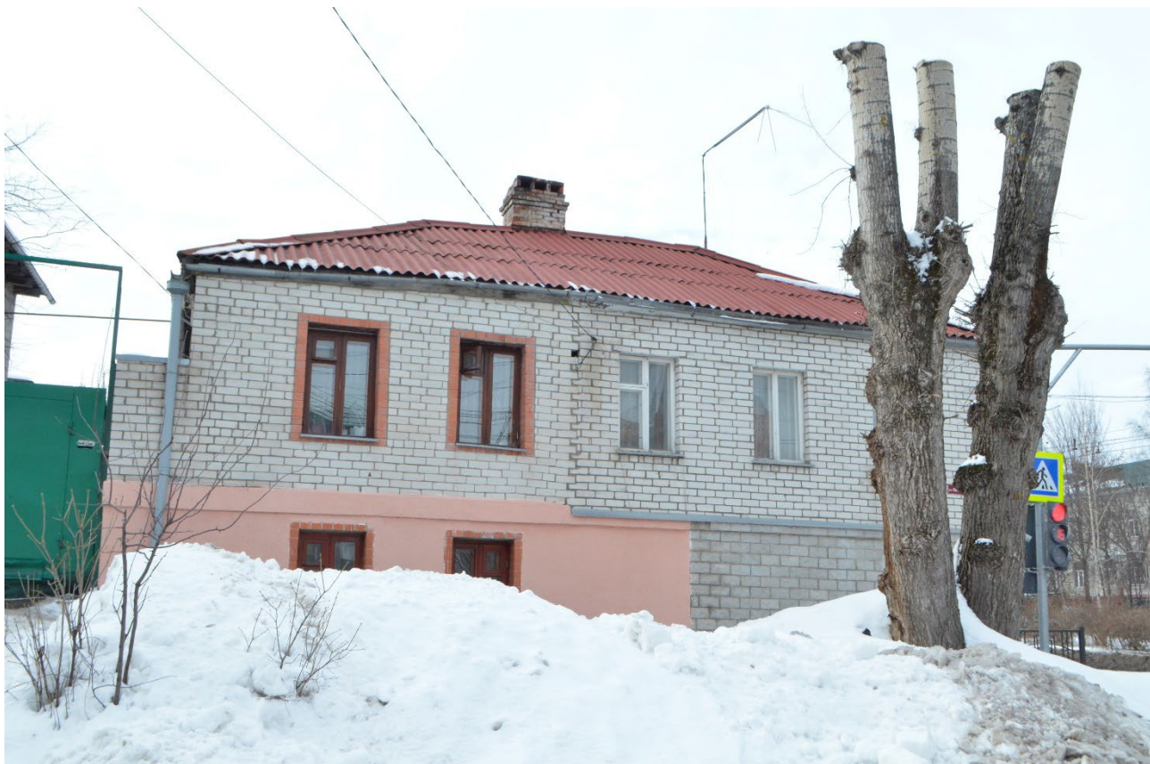
Т.ф. 3. Вид с востока со стороны ул. Овечкина на главный фасад Объекта
