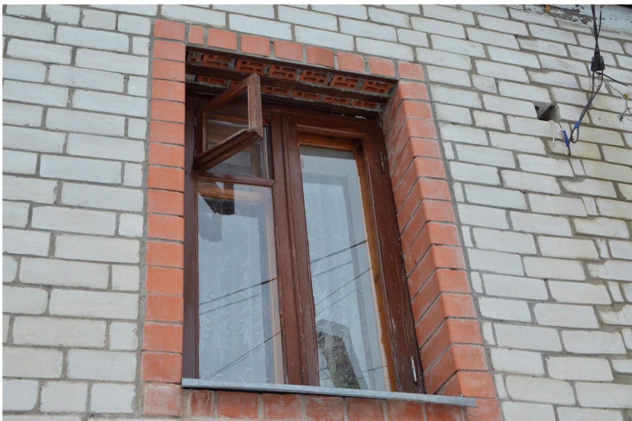
Т.ф. 8. Вид на окно второго этажа фасада Объекта со стороны ул. Овечкина
