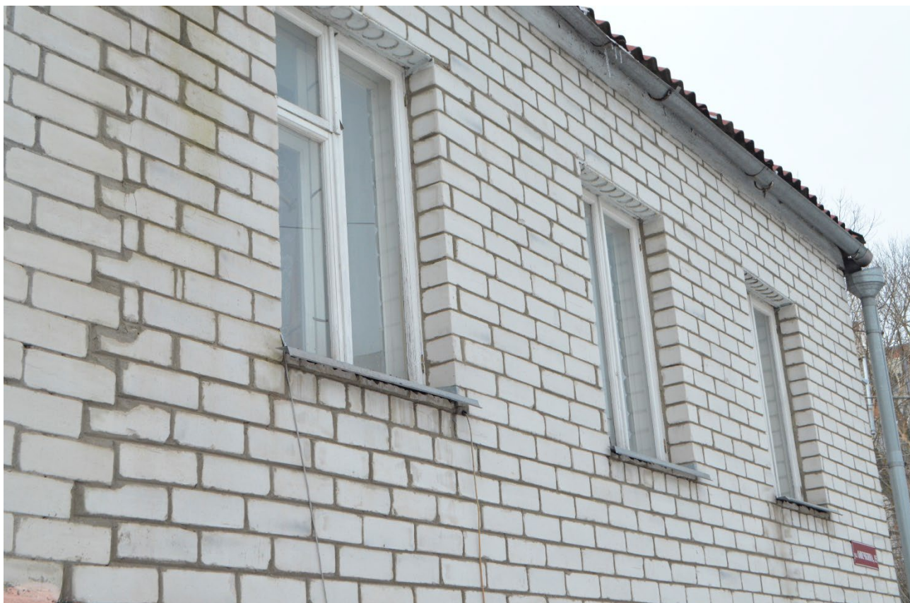
Т.ф. 9. Вид на окна второго этажа фасада Объекта со стороны ул. Овечкина
