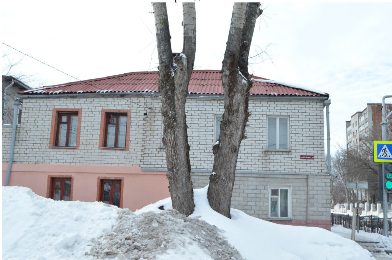
Т.ф. 2. Вид с северо-запада на лицевой фасад Объекта со стороны ул. Овечкина
