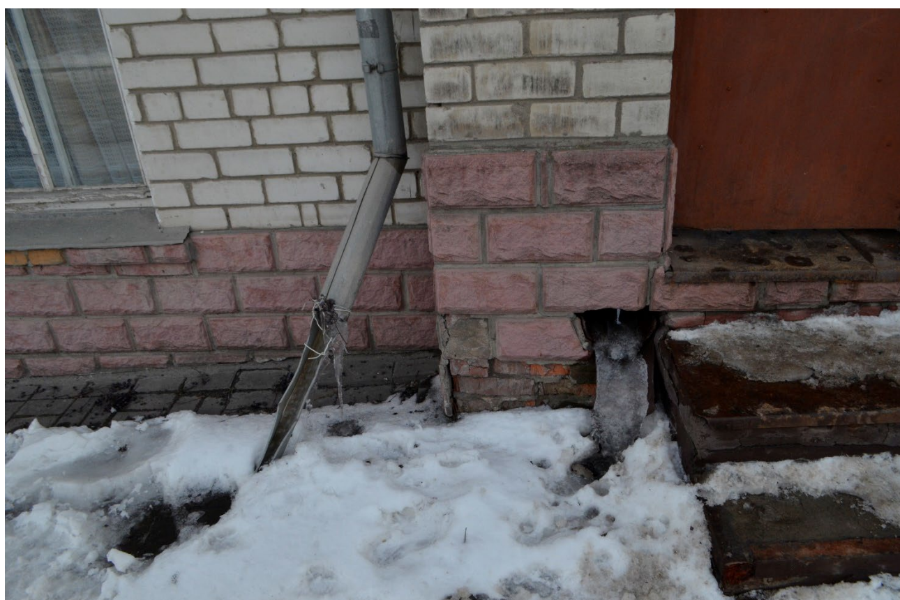
Т.ф. 12. Вид с севера со стороны ул. Красной Армии на отделку главного фасада Объекта
