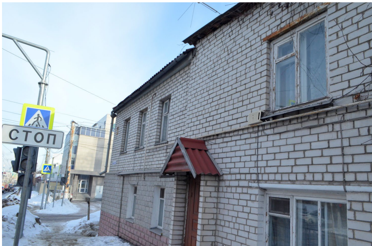
Т.ф. 11. Вид с запада на северо-западный фасад Объекта
