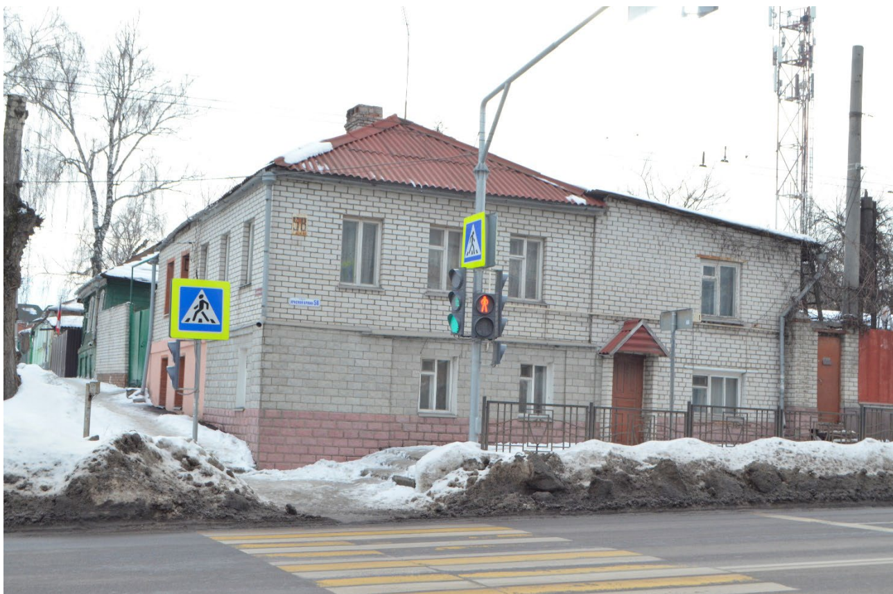
Т.ф. 6. Вид с севера со стороны ул. Красной Армии на главный фасад Объекта
