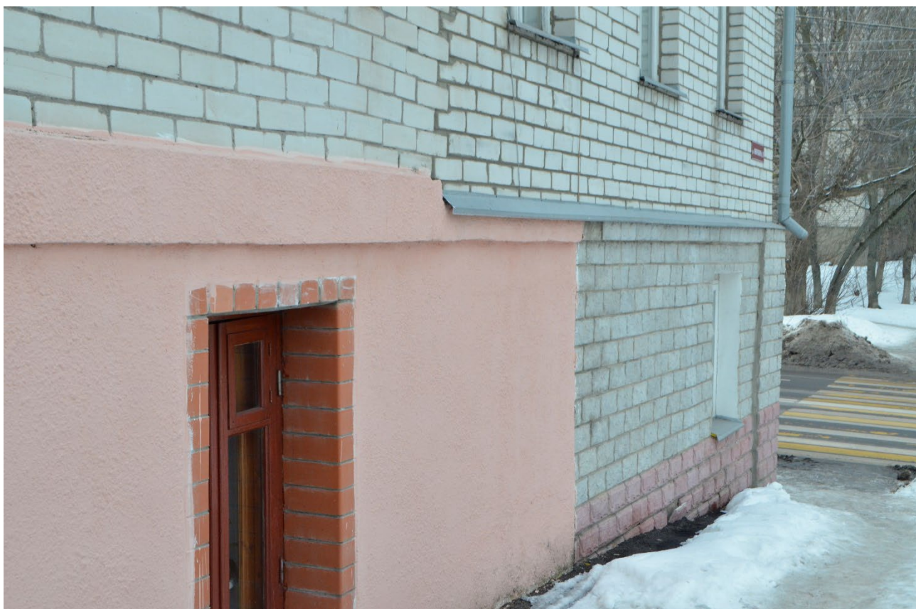
Т.ф. 10. Вид с востока со стороны ул. Овечкина на главный фасад Объекта
