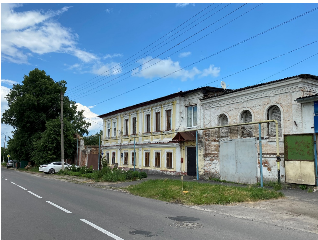
Фотография № 8. Вид с юго-запада на Объект.
