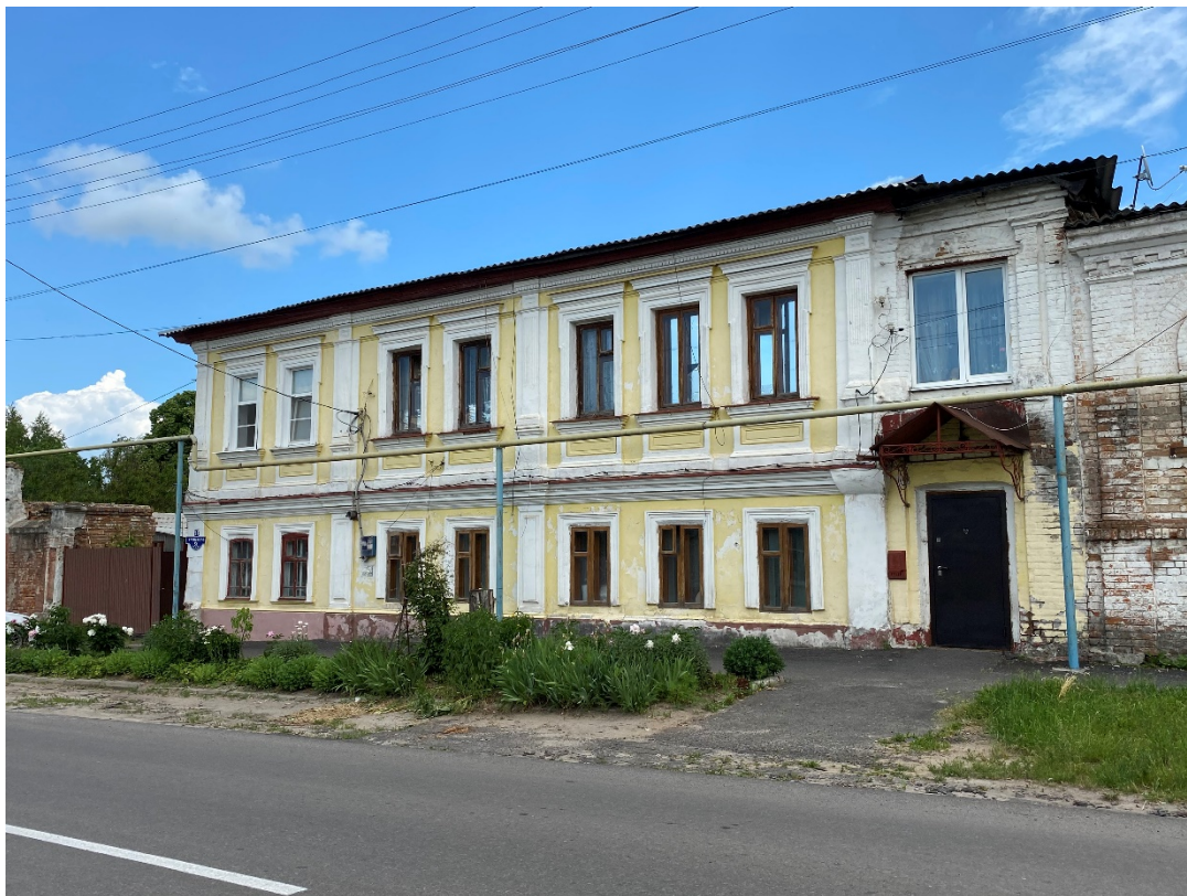
Фотография № 7. Вид с юго-запада на Объект.
