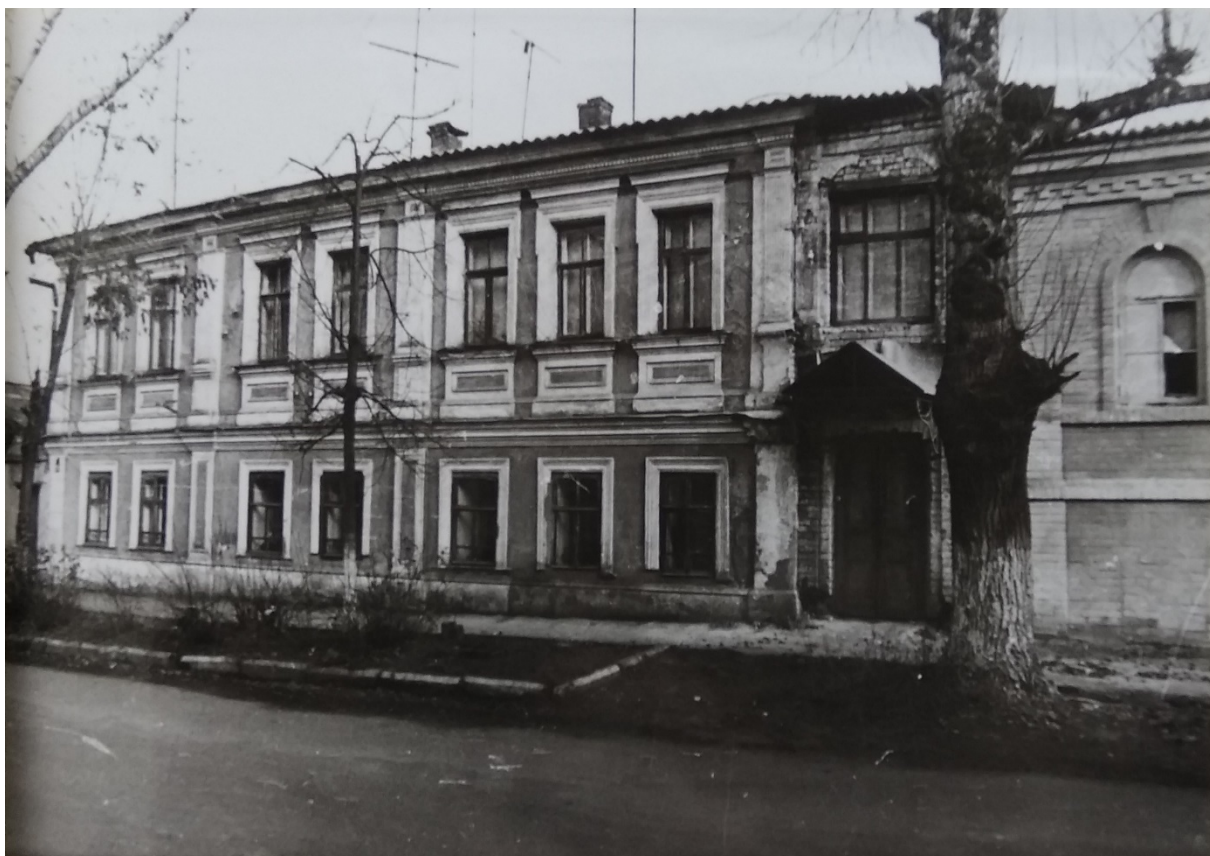
16. Дом по ул. Урицкого, 51. Здание Объекта на фотографии в «Проекте охранных зон г. Рыльска Курской обл.» 1990 года.
