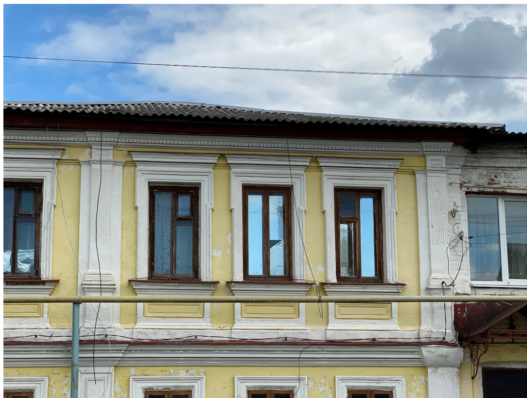
Фотография № 10. Вид с запада на Объект. Центральный фасад. Фрагмент.
