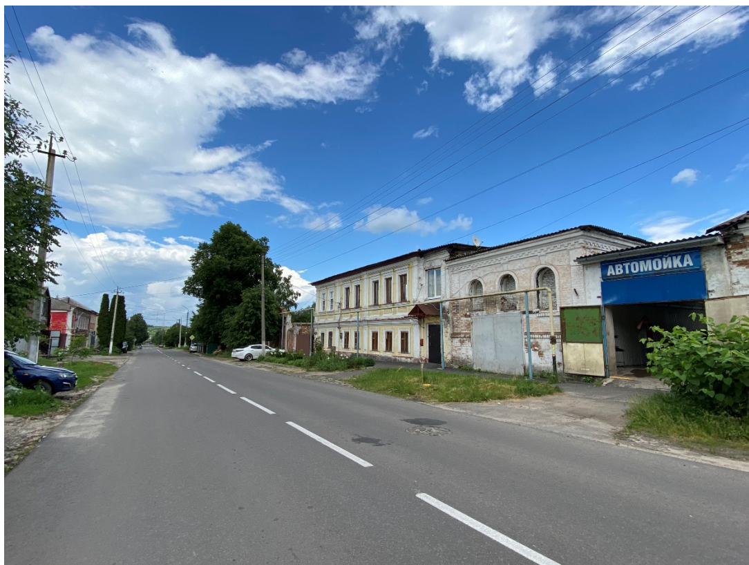
Фотография № 9. Вид с юго-запада на Объект.
