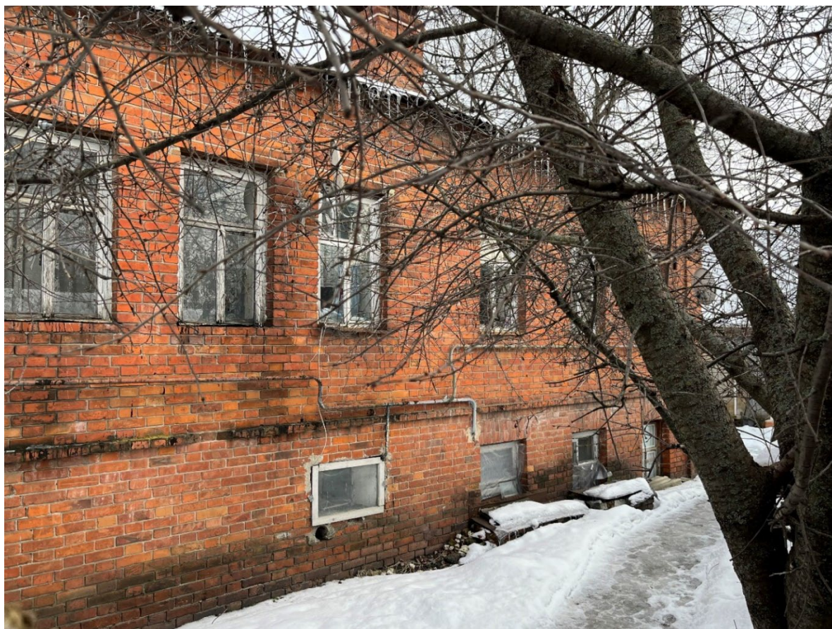
Т.ф. 11. Вид с северо-запада на юго-западный фасад Объекта
