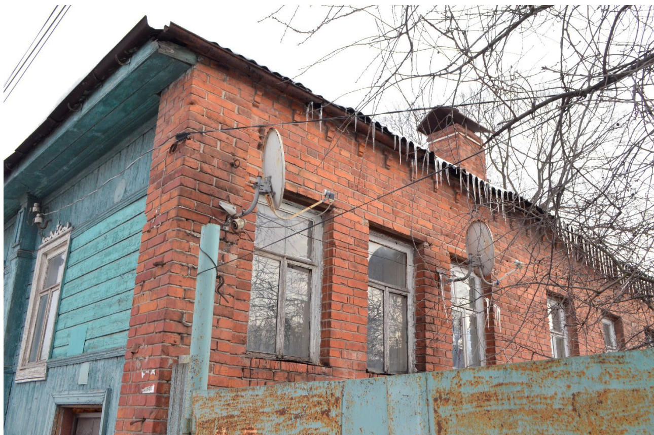
Т.ф. 5. Вид с запада на юго-западный фасад Объекта
