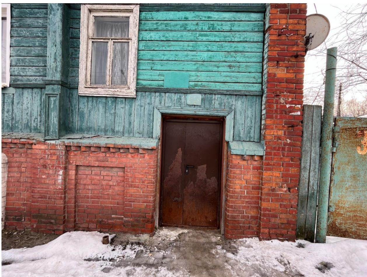
Т.ф. 16. Вид с севера на вход на главном фасаде Объекта
