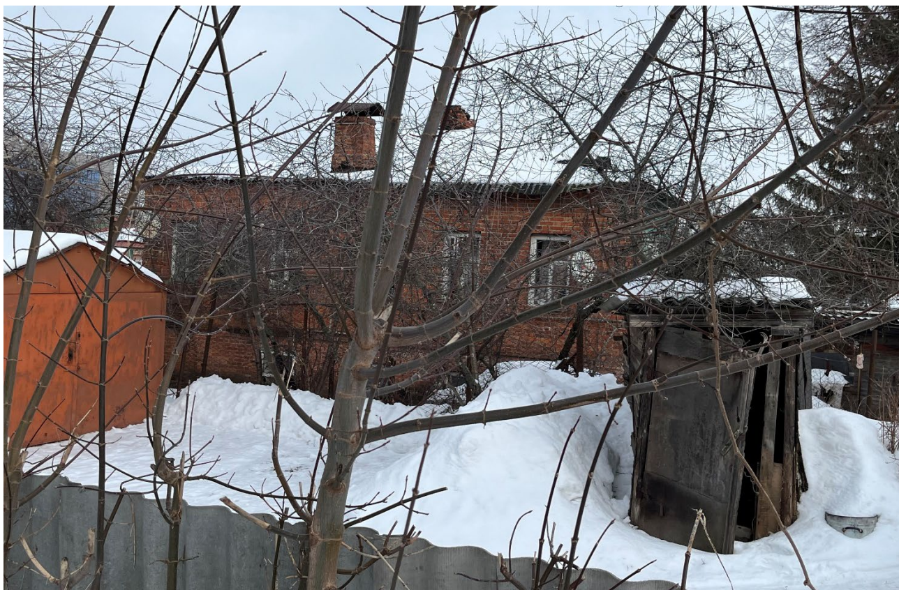
Т.ф. 10. Вид с юга на юго-западный фасад Объекта
