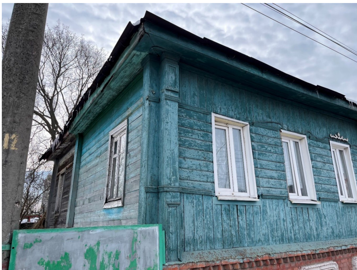
Т.ф. 12. Вид с севера со стороны ул. Красной Армии на главный и северо-западный фасады Объекта
