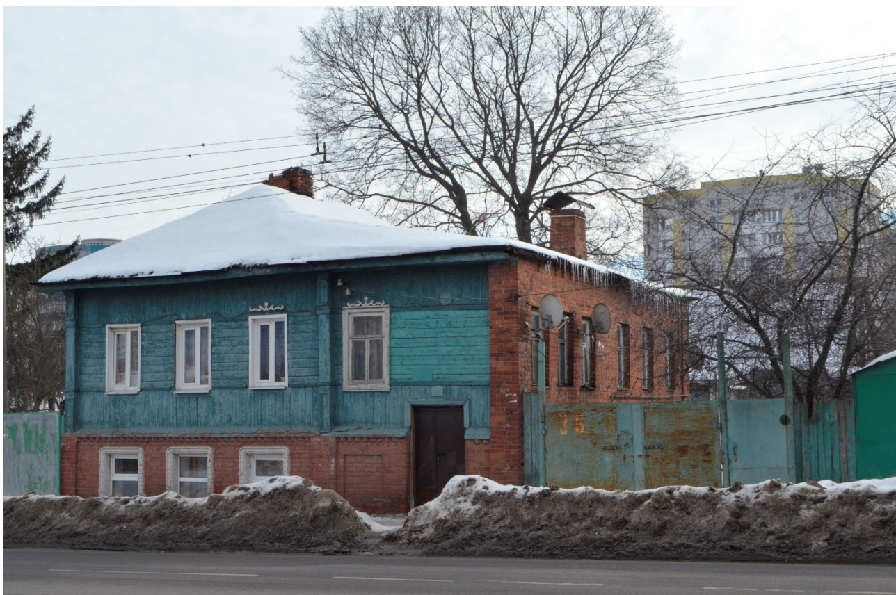
Т.ф. 3. Вид с северо-запада со стороны ул. Красной Армии на главный фасад Объекта
