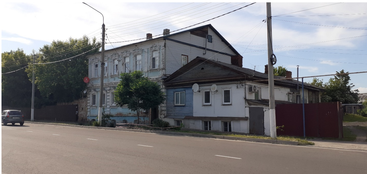
Фотография № 3. Вид с юго-востока на Объект.
