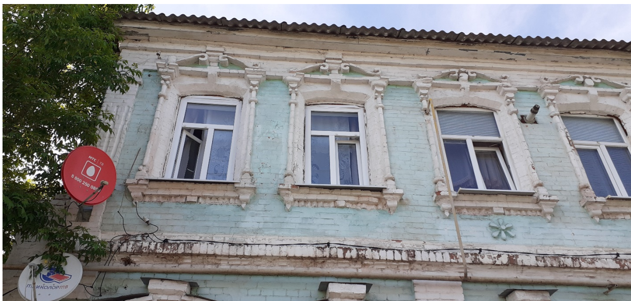
Фотография № 8. Вид с юга на Объект. Центральный (южный) фасад. Фрагмент.
