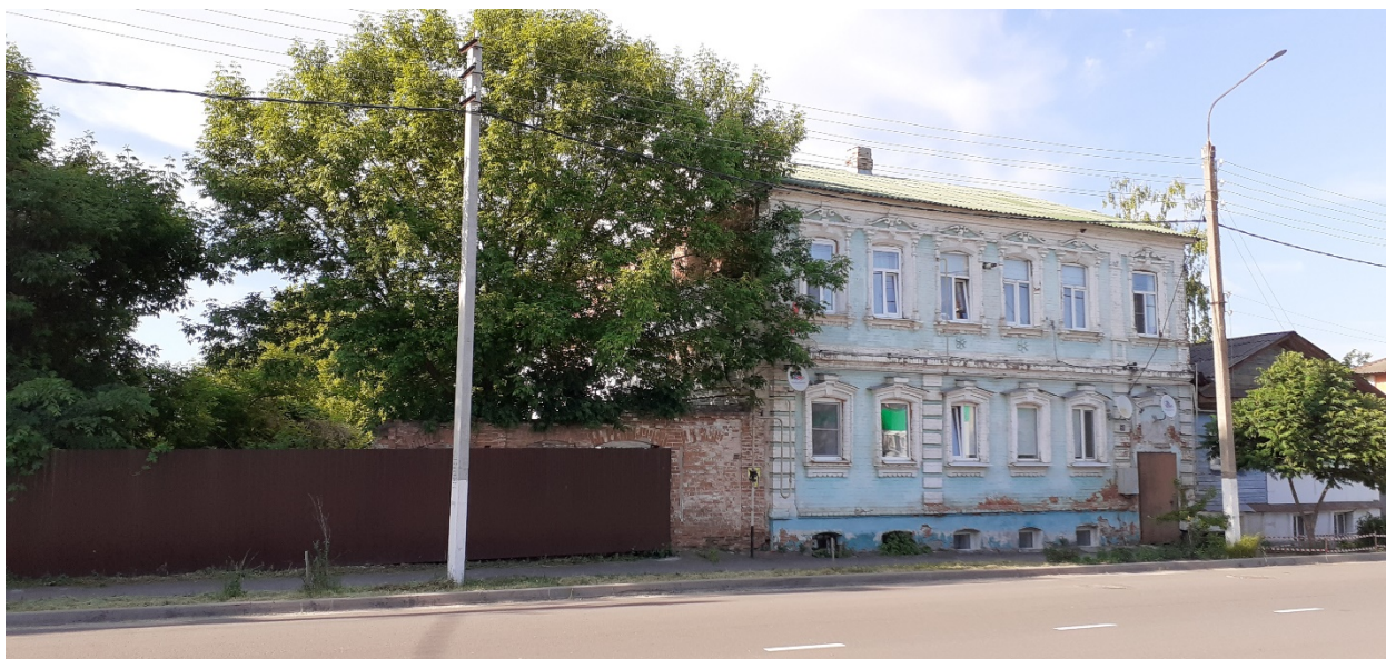
Фотография № 7. Вид с юго-запада на Объект.
