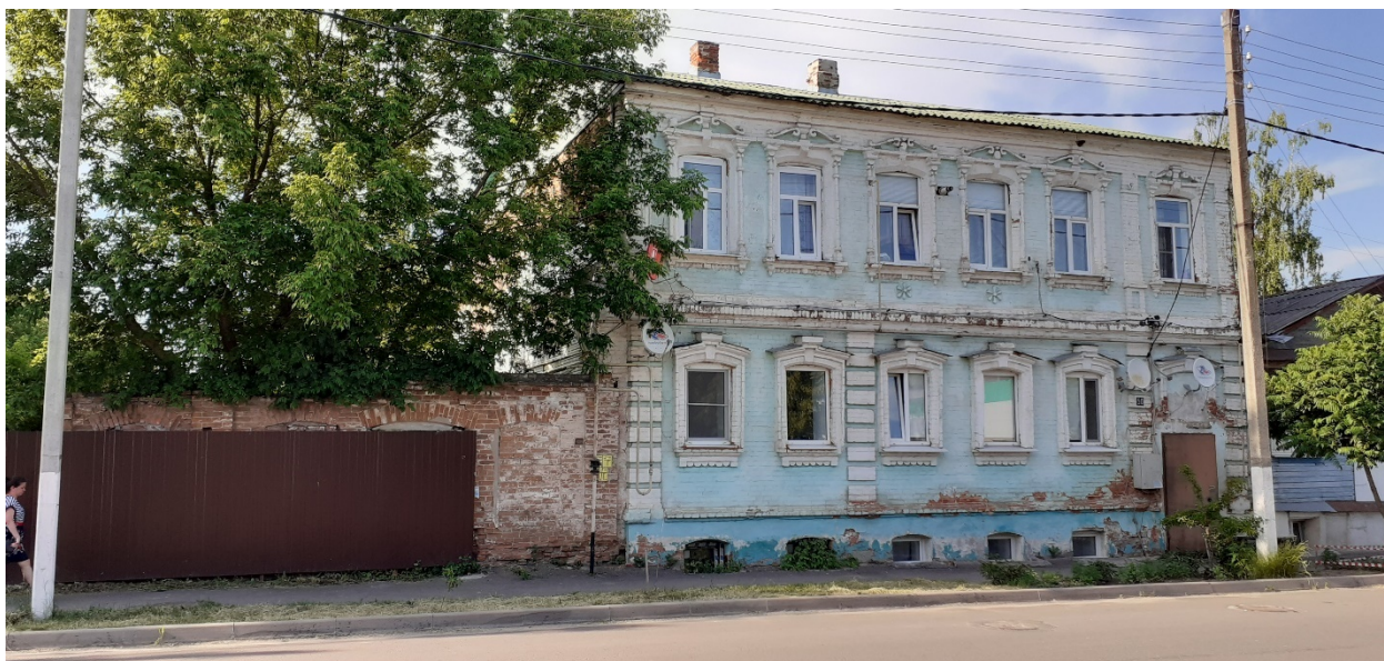
Фотография № 6. Вид с юго-запада на Объект.
