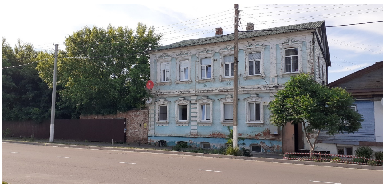
Фотография № 4. Вид с юго-востока на Объект.
