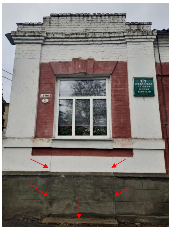
Рис. 21. Выявленный объект культурного наследия «Дом купца Тараканова» Курская обл., г. Суджа, ул. 1 Мая, 21. Главный фасад. Фрагмент. Западный ризалит. Стрелками показаны места заложения дверного проёма и сохранившаяся каменная ступень перед бывшим входом. Фото Оболенской Н.С. Ноябрь 2021 г.
