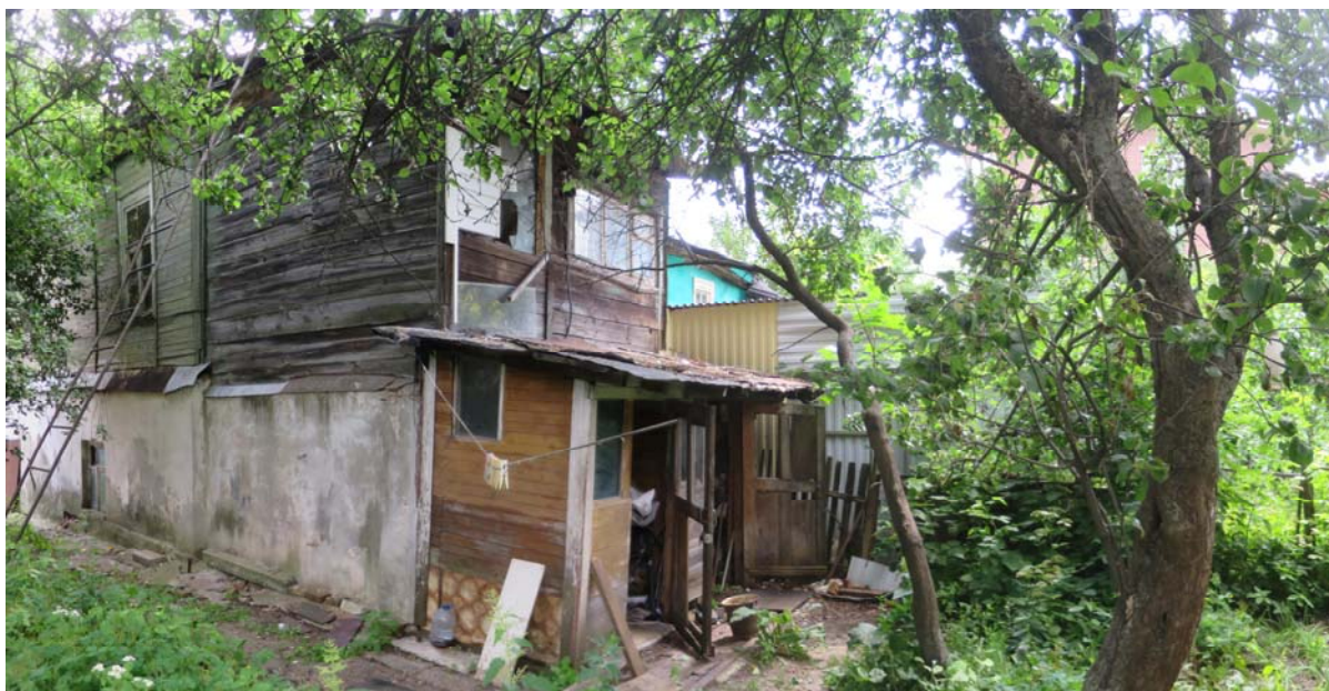
6. Вид с северо-запада со двора.
